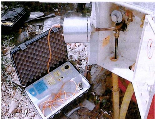
ウルトラソニック・エネルギーを PE パイプに送信。
